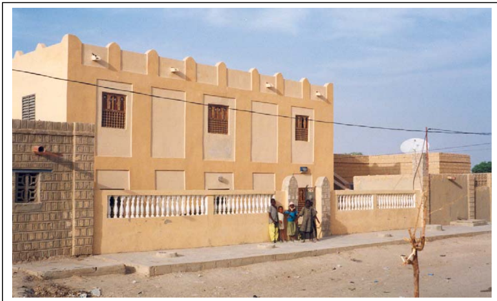
Edificio construido por la Junta de Andalucía en Tombuctú donde actualmente se guarda el Fondo Katí.
